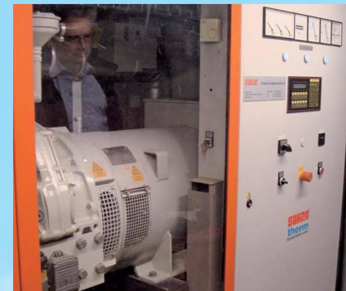
Die vom Blockheizkraftwerk im Schulhaus Robersten erzeugte Energie, sowohl der Strom und die Wärme, werden in das bestehenden Fernwärme- und Stromnetz eingespeist. Fotos Oskar E. Aeberli
